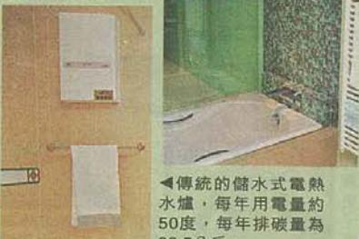
►傳統的儲水式電熱水爐，每年用電量約50度，每年排碳量為32.5公斤。
