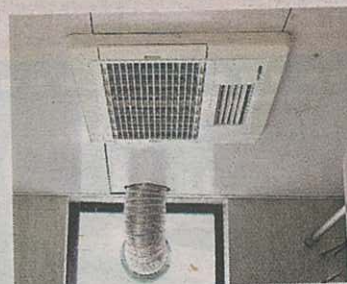
▶天花安裝連合一道直徑達4吋的排氣管，可排走濕熱的空氣。
