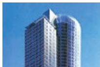
德國法蘭克福主塔 Main Tower, Frankfurt
